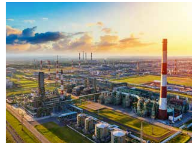
NHÀ MÁY NHIỆT ĐIỆN 火力发电厂
